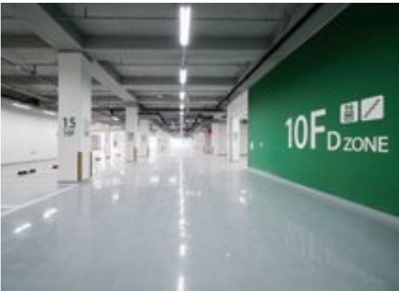
최대 6m의 광폭도로로 대형차량의 양방향 통행이 가능하며 10층까지 도로가 연결되어 있어 물류 운반이 더욱 편리하다.
